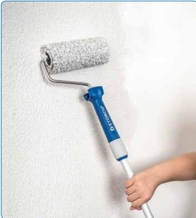
Durch die Rollspachtel-Walze GreyTOP wird der Materialauftrag gleichmäßig und sorgt für eine optimale Vorbereitung der nachfolgenden Arbeitsschritte.
